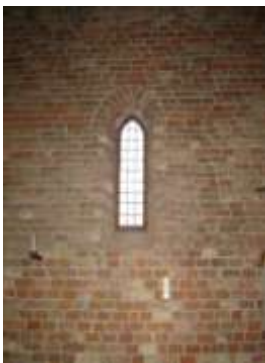
Spitsboogvenster in de zuidmuur
