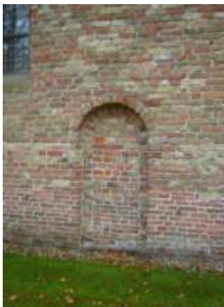
De gesloten Romaanse ingang aan de noordkant
