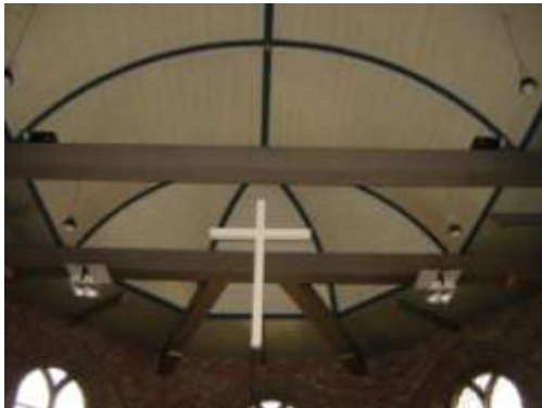
De trek balken zijn ombergrijs en bladgoud bekleed. De kroonluchter en ingebouwde buislampen.
