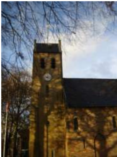
De zuidkant met dichtgemetselde ingang
