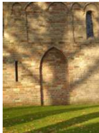
De gesloten Gotische ingang aan de zuidkant
