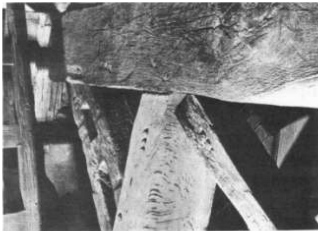
balkenconstructie met halve maantjes
